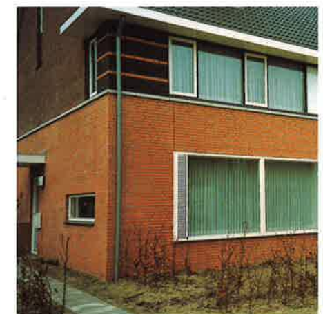
Dilatatie zelfdragende latei met onvoldoende stijfheid
