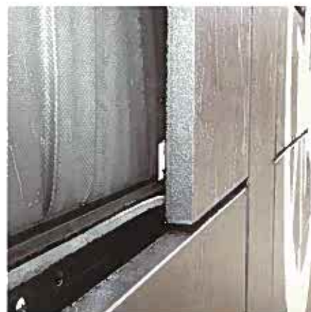
Figuur 10. Detail buitenisolatie met keramische platen
