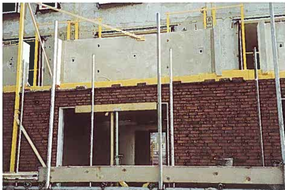
Figuur 6. Metselwerk afgedekt tegen inwateren
