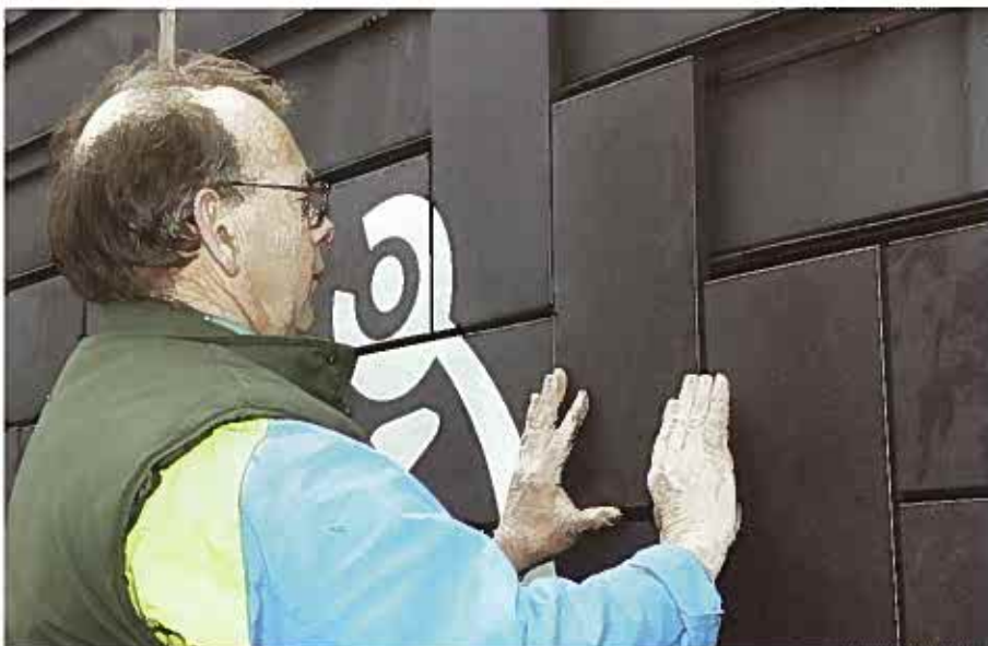
Figuur 9. Buitenisolatiesysteem met keramische gevelplaten (St. Joris)
