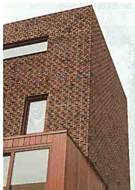
Figuur 8. Klampverlijmde baksteen met frog, nieuwbouw Hoofddorp. (arch. ir. Kees Christiaanse, Architects & Planners, Rotterdam)
