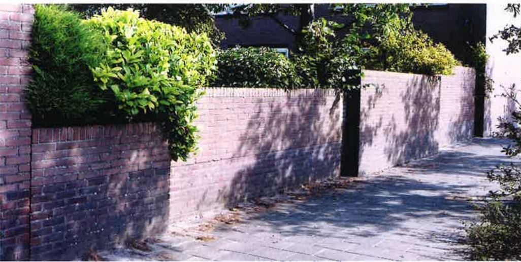
Figuur 4 Tuinmuur halfsteens met steens penanten. De halfsteens muren zijn wisselend aan voor- en achterzijde van de penanten geplaatst. (Foto: Grid Design)
