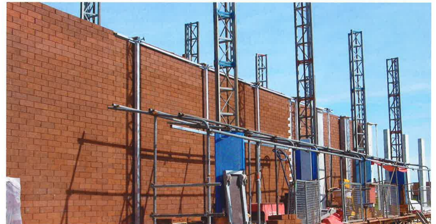
Figuur 15 De muur tijdens de uitvoering. De ellipsvormige onnmuring van het complex is gebouwd als spouwmuur. De muur ontleent haar stabiliteit aan in de fundering ingeklemden kolommen, die in de brede spouw zijn opgenomen. De spouwbladen zijn met een folie losgebonden van de kolommen, zodat zij vrij kunnen bewegen bij temperatuurverschillen. De verrijdbare hefsteiger werd speciaal voor het project ontwikkeld. De muur heeft een totale lengte van 660 meter. Foto: Loof & van Stigt architecten B.V., Amsterdam.
