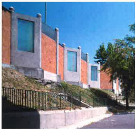
Figuur 10 Geluidsmuur met geknikte vorm.
