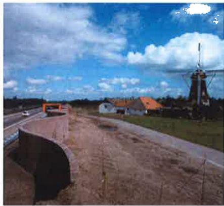
Figuur 9 Geluidsmuur met gebogen vorm.
