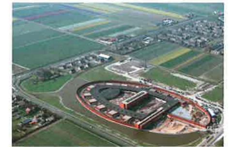
Figuur 14 Vrijstaande muur van ca 5 m hoog rond het complex van de Rijk 'De Doggersbank' in Den Helder. De muur is vervaardigd van gelijmde bakstenen. Architect: Loof & van Stigt architecten B.V., Amsterdam. Foto: Snow-White fotografie / Moniek Mulder, Weesp.
