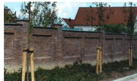
Figuur 7 Tuinmuur met penanten. (Foto: Frank Struijk)
