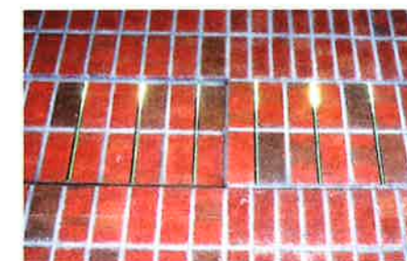
Figuur 21 Detail geluidsmuur met ingemetselde glasplaten.
