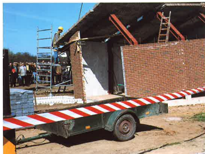
figuur 3 Voorgespannen geprefabriceerd gevelement
