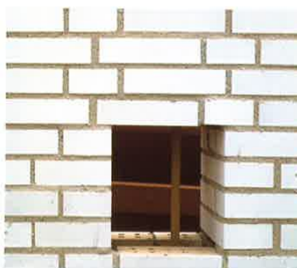
figuur 7 Met aramidewapening voorgespannen wand Autotron Rosmalen
